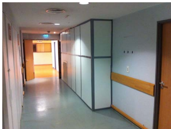
Cloisons provisoire au N1
