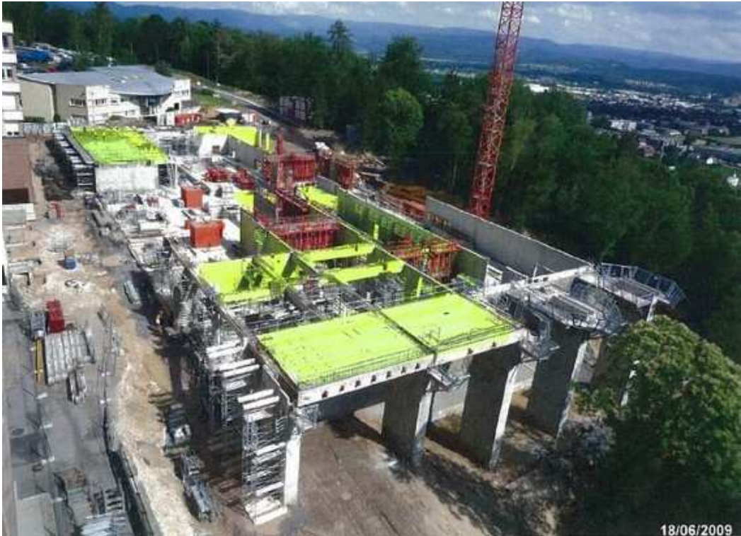
Planchers sur méga poteaux
