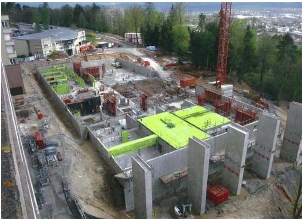
1ers planchers haut du sous-sol
