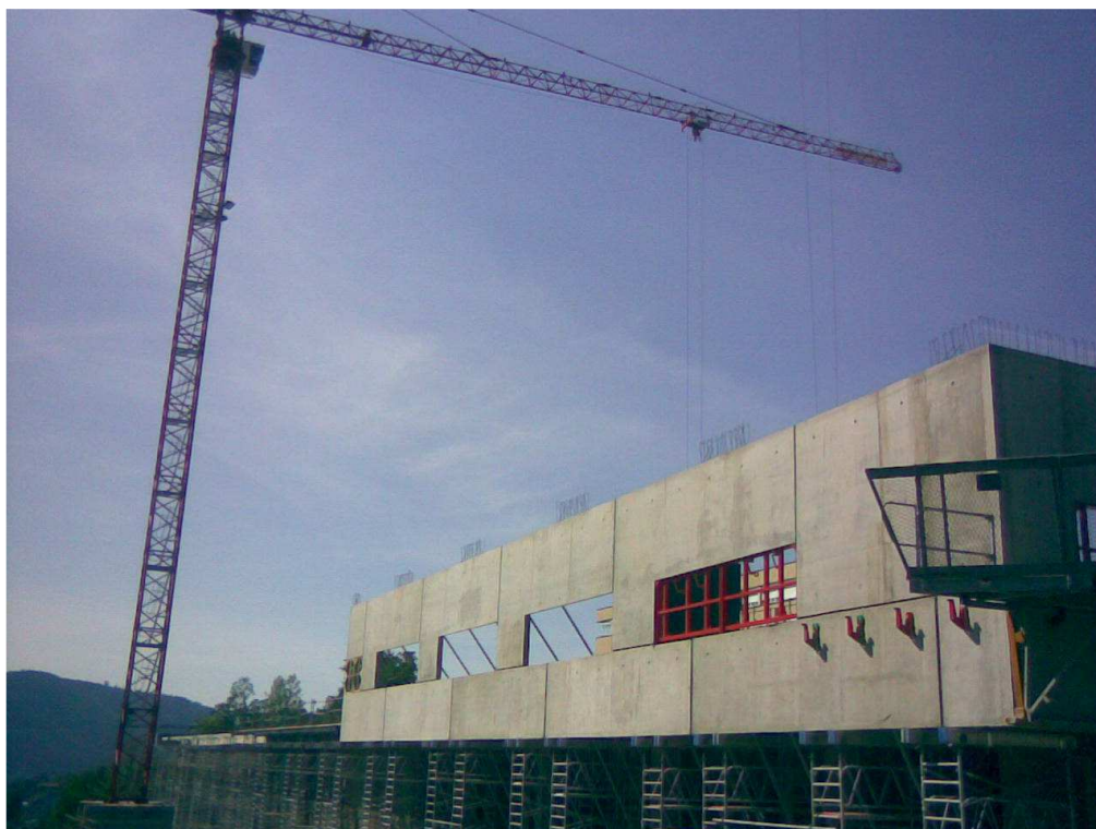
1 er voiles (murs) de façade
